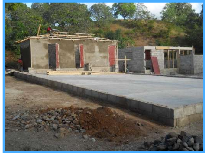
L'ensemble des bâtiments avec l'aire de séchage en béton
