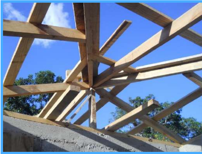
La charpente du toit vue de l'intérieur du bâtiment
