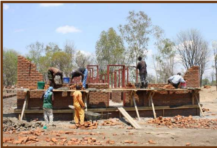
Les poseurs de briques à l'œuvre
