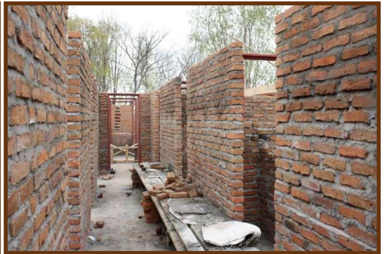
Les murs sont presque terminés!
